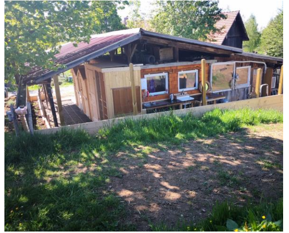
Dusche, WC, Abwaschstation von aussen
